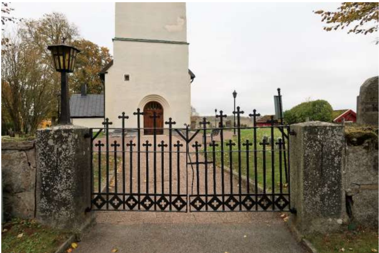
Huvudentrén i väster med par grind av smide mellan grindstolpar av granit. Lyktorna som kröner grindstolparna tillkom någon gång efter 1943.
