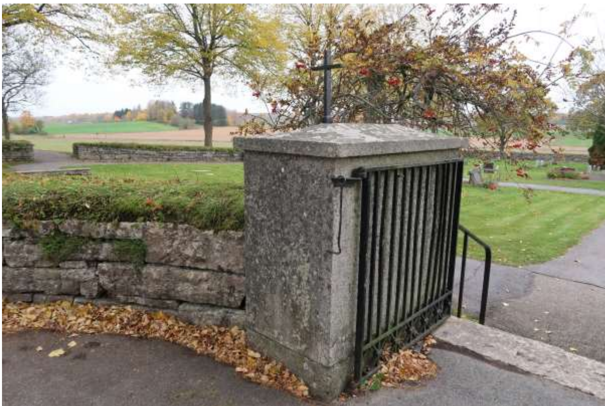
Västra kyrkogårdens huvudentré med djupa grindstolpar av granit krönta med överliggare och kors. Grindstolparna har en krysshamrad yta och korsen en hamrad yta.
